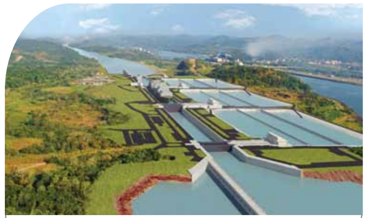
Las nuevas esclusas utilizarán tinas laterales de ahorro de agua
